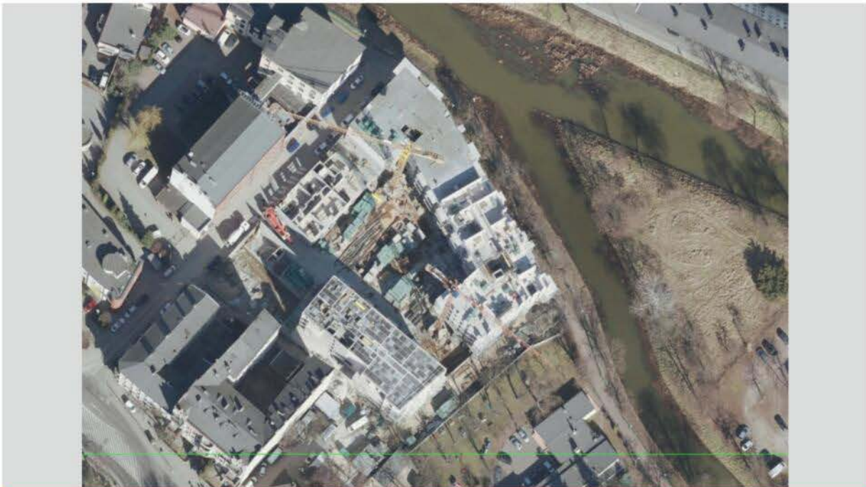
RiverSide w budowie, Kalisz, źródło: Geoportal Krajowy
